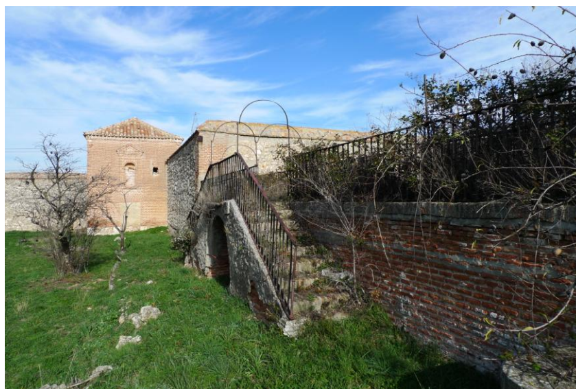
FIG.111. Detalle de la escalera de comunicación entre el estanque mayor y el jardín alto del convento; la escalera tiene una barandilla de hierro forjado y pies derechos para formar una pérgola.
