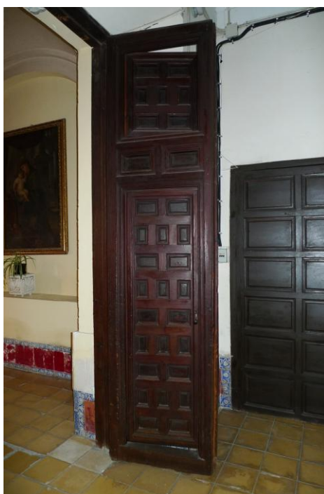
FIG. 83. Hoja de las puertas de acceso originales al claustro desde el zaguán de Loeches, con los plafones de nogal negro. El pavimento visible de baldosa hidráulica, se colocó en los años 60 del siglo XX.
