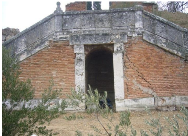
FIG. 113. Vista de la escalera de comunicación entre la primera y la segunda terrazas, con tramos enfrentados. Bajo el dintel con arco situado en su eje, se conserva la conducción primitiva de aguas que surtía a la huerta inferior.
