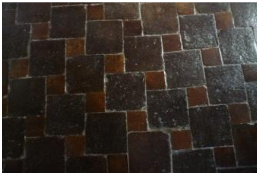
FIG.12. Detalle del despiece del pavimento cerámico original del Salón de Embajadores del Monasterio de El Escorial. (Foto del autor).
