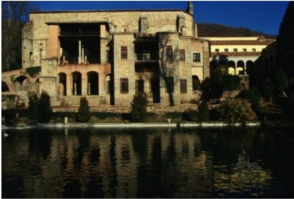
FIG.8. Fotografía de la fachada sur del Palacio de Yuste (2004.); a la derecha, la galería porticada en "U" en dos plantas, la superior con arcos de medio punto, aun cuando en el grabado de Wyngaerde la estructura es adintelada en esa planta.
