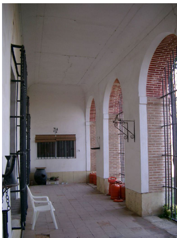
Fig. 82. Pavimento de baldosa de barro en el interior del atrio norte del convento, con las basas de los pilares de ladrillo entre arcos de sillería caliza.
