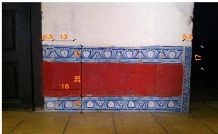
FIG. 78. Zócalo de la planta baja del convento con el motivo de flor de lis y papo de paloma; a la derecha, en la arista, cantonera a base de olambrillas con dibujo de greca.
