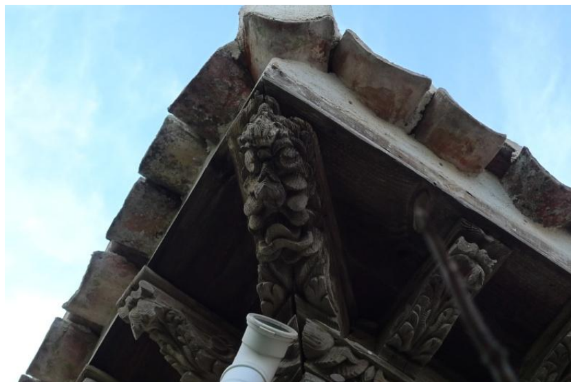
Fig.132. Vista frontal, inferior y lateral del can de esquina grotesco de Loeches.
