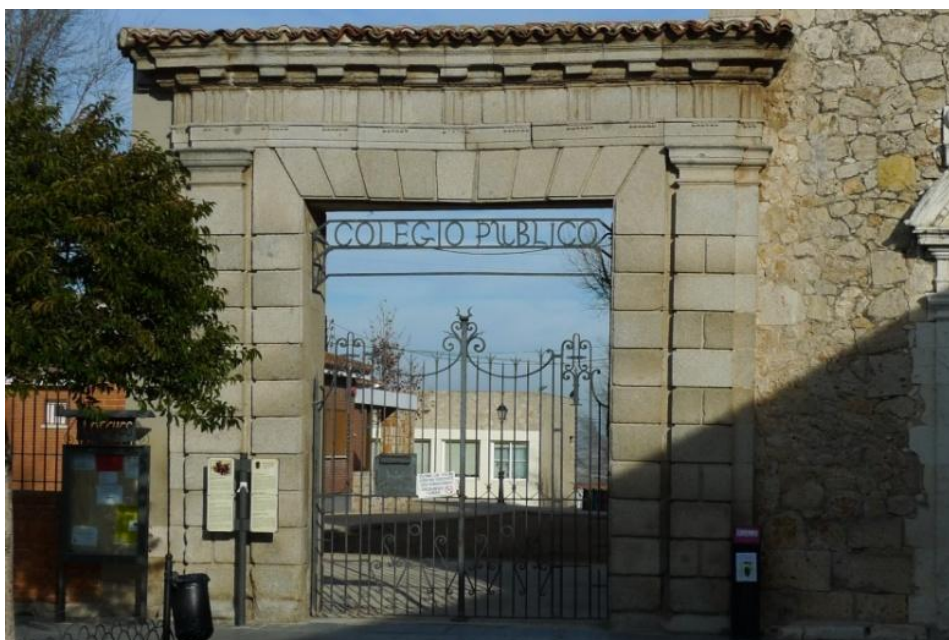
FIG.96. Imagen de la portada original del alzado sur del palacio; a la izquierda, el muro revela la situación de los huecos del semisótano, que fueron rellenados con ladrillo para reutilizar el zócalo como cerca del colegio; a la derecha, la iglesia del convento carmelita.
