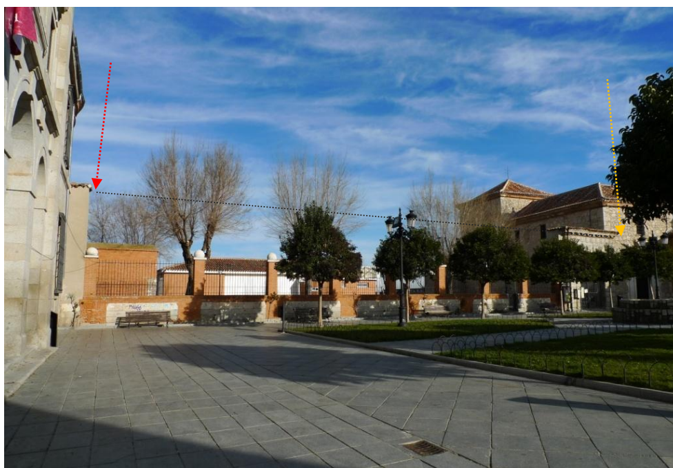
FIG.97. Imagen desde la plaza del basamento del alzado sur del palacio, reutilizado como tapia del patio del colegio; a la izquierda, y marcado con una flecha roja, un machón rematado por teja que es el resto del primitivo muro demolido de la fachada e indicativo de su línea de alero (en línea discontinua gris); a la derecha y con una flecha naranja, la portada del palacio visible y su entronque con la iglesia carmelita.
