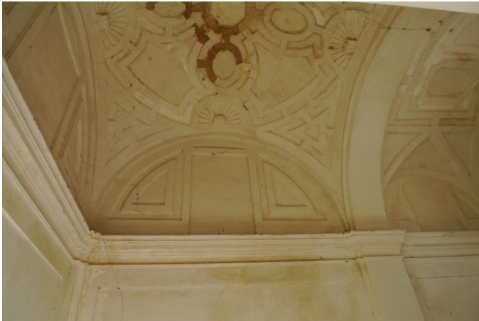
FIG. 67. Vista del interior abovedado de la capilla Norte, con la cúpula vaída encamonada con decoración de lazo y labor en que la elipse es protagonista.
