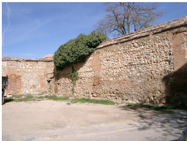
FIG. 72. Muro o cerca exterior, compuesto de machones de ladrillo y “cajas” de mampostería.
