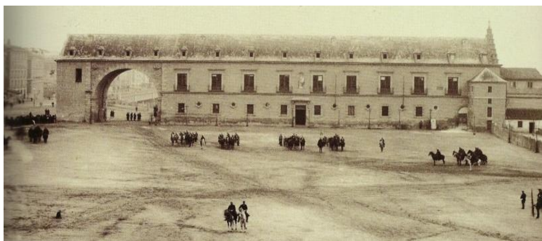
FIG.34. Fotografía de la Armería, de J. David, antes de su destrucción en 1884. Albúmina esmaltada, 16,5x23cms. Patrimonio Nacional. Madrid. Archivo General de Palacio.
