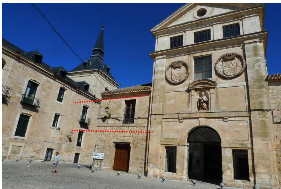
FIG.20. Fachada del convento dominico de San Blas; con revoco liso se aprecian las improntas en la fachada este del palacio ducal de los restos del pasadizo sobre arcos hoy desaparecido, recreado con una línea roja discontinua. (Foto del autor).
