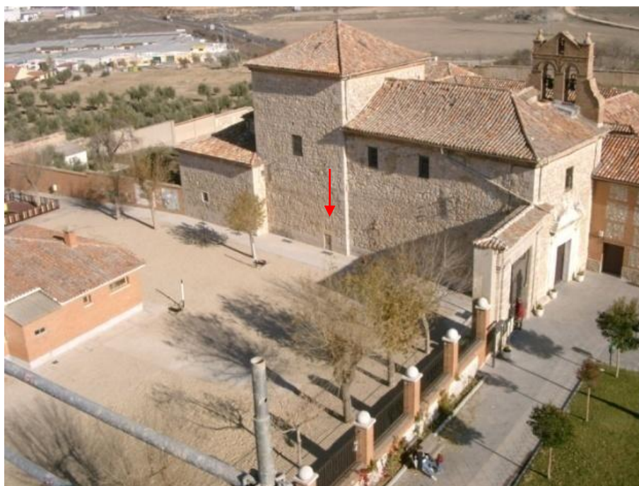
FIG.32. Foto del estado actual de la fachada oeste (evangelio) de la iglesia de las carmelitas de Loeches. Con una flecha roja se ha señalado el paso tapiado que comunicaba la iglesia con la desaparecida Casa de los Cárdenas, propietarios de Loeches antes de la adquisición del señorío por los Olivares. Véase también la portada del palacio desaparecido y su zócalo, reaprovechado como cerramiento del patio del colegio Duque de Alba.
