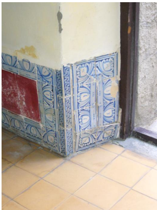
Fig.122 Alicer ó zócalo de azulejería de Loeches y de sus cantoneras.
