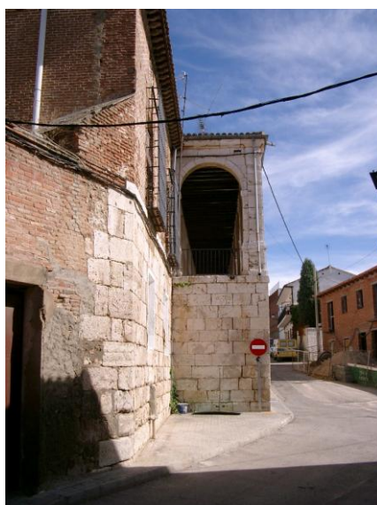
FIG.49. Vistas desde el oeste de la galería sur de arcos de cantería; se aprecia el desnivel exterior.
