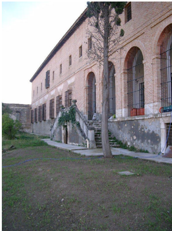
FIG. 80. Escalera de acceso desde la fachada norte conventual ("galería del cierzo"), al jardín-huerta alto.
